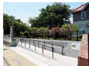
アプローチ用スロープ
